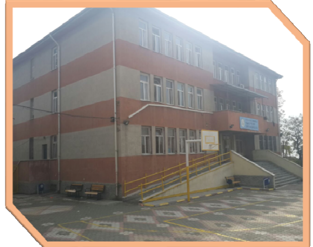
B BLOK GENEL GÖRÜNÜM
